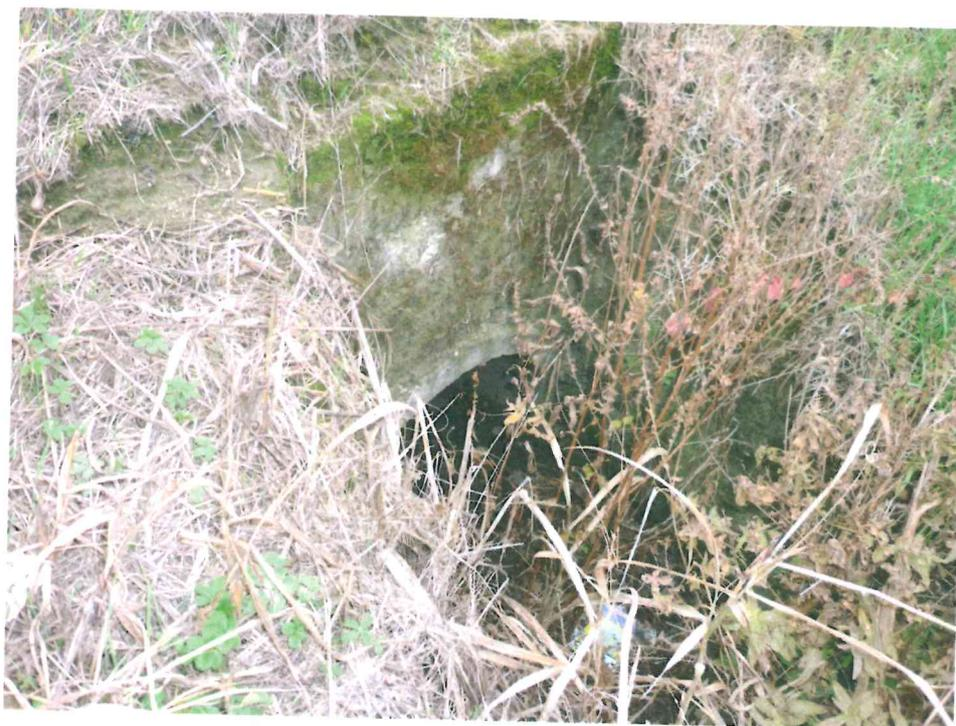
Foto 3.3 – Particolare della tubazione interrata che attraversa la sede di Corso Asti in uscita dal fosso in terra.
