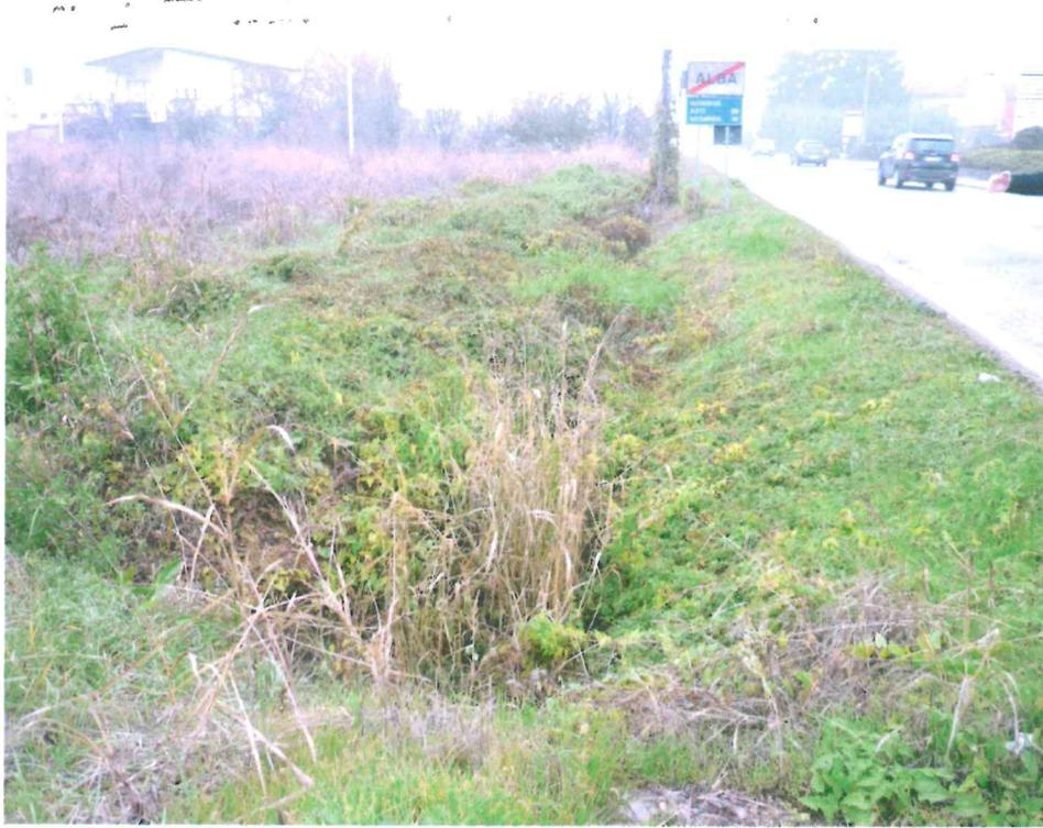
**Foto 3.2** – Panoramica dell'esistente fosso in terra (ripresa da SW), dove si evidenziano le carenti condizioni di pulizia e manutenzione.
